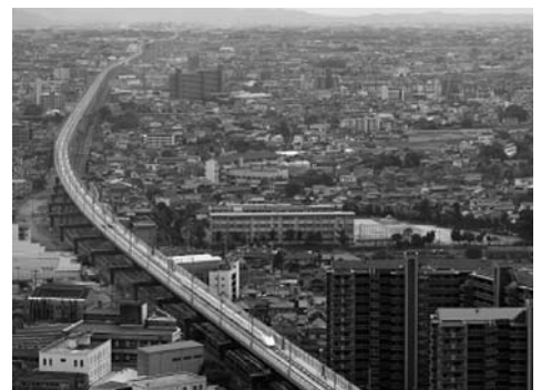
松原線路橋全景
